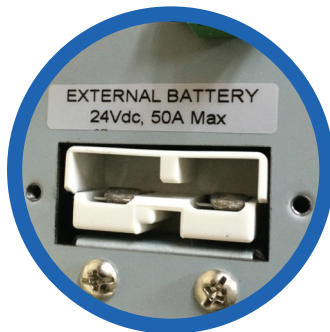
Entrada banco de baterías externas
